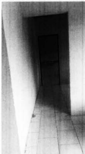
Imagem 03 – Serviços de pintura de esquadrias e paredes
