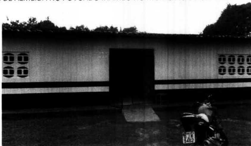
Imagem 01 – Serviços de Pintura e recuperação de calçada
