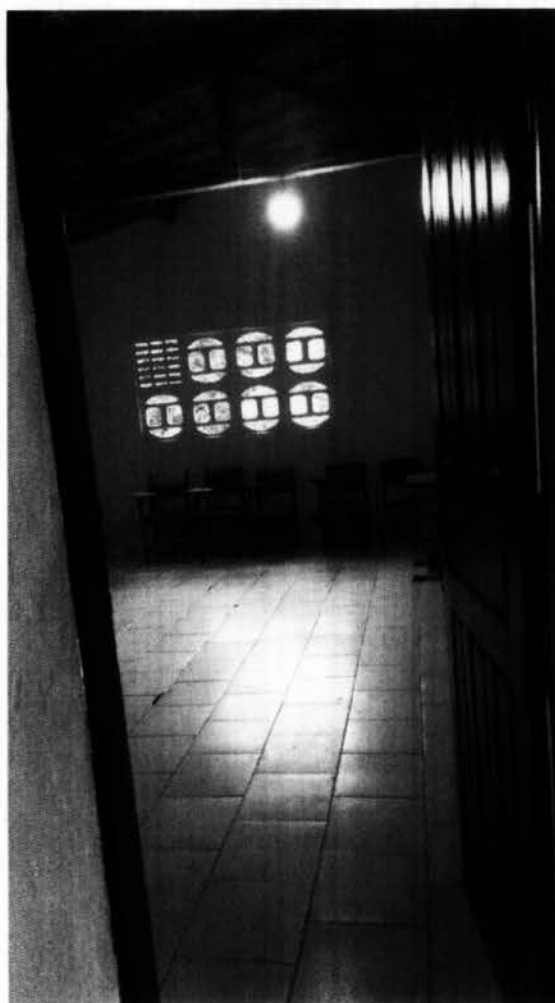
Imagem 04 – Serviços de pintura de esquadria e paredes
